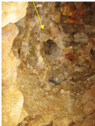
TA 1 (trou d'aération 1) - au plafond un petit trou circulaire donne accès à la surface
