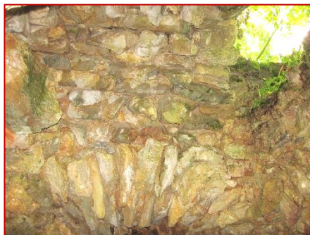
Afin de créer le PROM 2 on scelle les anfractuosités ou les tranchées de surface par des arcature en arc de cintre au plafond
