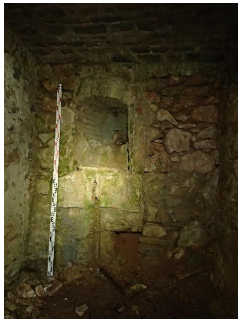
« L'évier » du LV avec au-dessous l'exutoire des eaux usées
