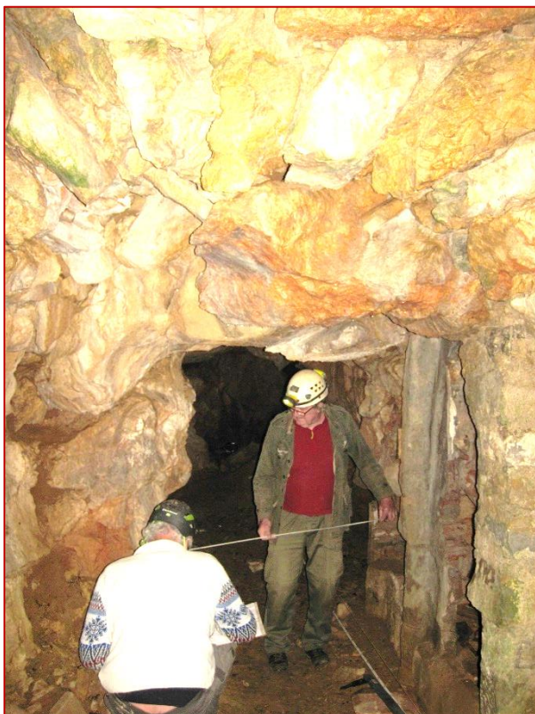
A la jonction galerie latérale (naturelle) et la crypte (artificielle) un assemblage de gros blocs disposés en position radiale et en cintre bloque le plafond (juste au-dessus de la sépulture).
